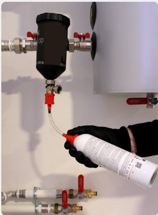
Injection du traitement via le pot à boues
